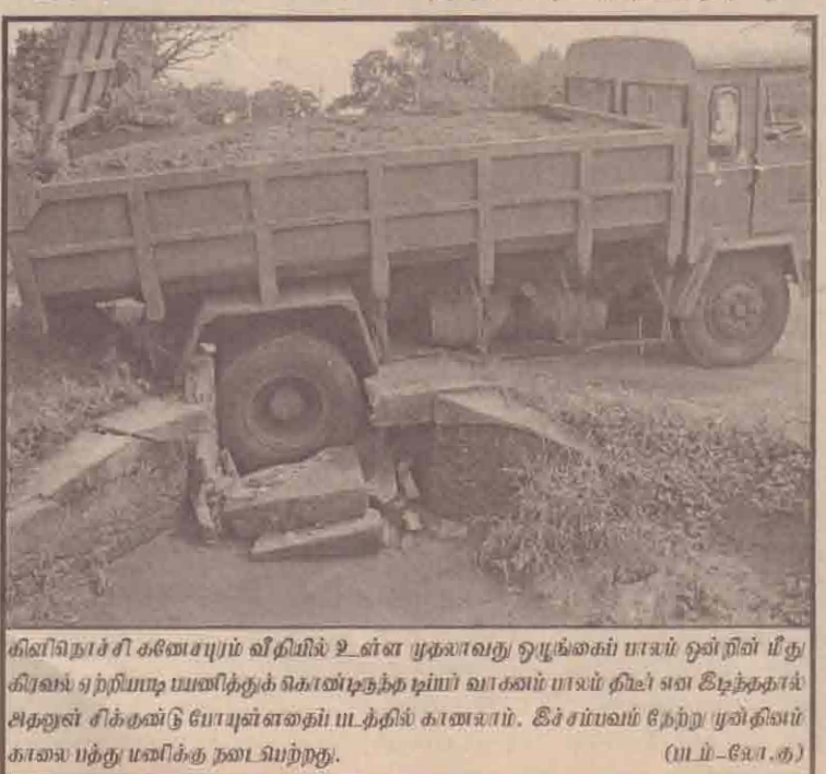
கிளிநொச்சி கணேசபுரம் வீதியில் உள்ள முதலாவது ஒழுங்கைப் பராம ஒன்றின் மீது கிரவல் ஏற்றியபடி பணிக்குக் கொண்டுவந்த பணம் வாசனை பராம திவ் என சீலத்ததால் அதனுள் சிக்கலுண்டு போயுள்ளதைப் பட்டத்தில் காணலாம். சீர் சம்பவம் நேற்று முன்தினம் காலை பற்று மணிக்கு நடைபெற்றது. (மம்-சோ.க)
