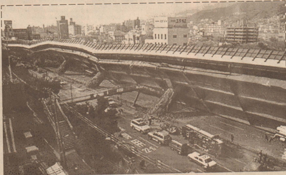
சனவரி 1995இல் யப்பானில் 6400 பேருக்கும் அதிகமானவர்களின் உயிர்களைக்காவுகொண்டு, லட்சக்கணக்கானவர்களின் இருப்பிடங்களை அழித்த நிலநடுக்கத்தினால் சரிந்து விழுந்த நீண்ட நெடுஞ்சாலை.
