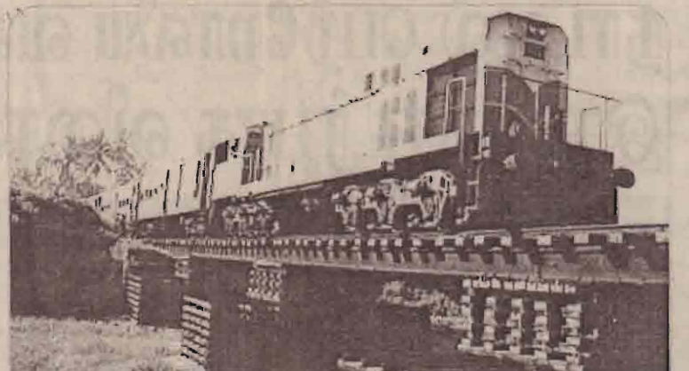
பின்வந்த பண்டு வர என்னும் இடத்தில் தற்காலிகமாக அமைக்கப்பட்டிருக்கும் ரயில்வே பாலம் ஆறுமாதங்களுக்கு மட்டுமே உத்தரவாதம் அளித்து ஒரு வருடத்திற்கு முன் அமைக்கப்பட்டது. சிலிப்பர் கட்டைகளின் ஆதாரத்துடனேயே ரயில்கள் ஓடுகின்றன.
