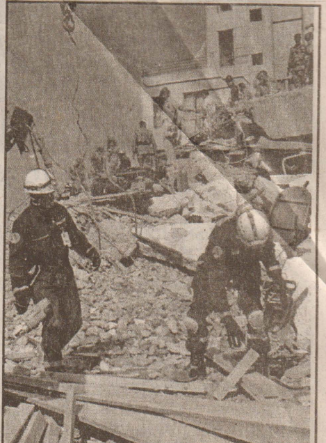
இஸ்லாமபாத்தில் பீரிட்டிஷ் இராணுவத்தினர் மீட்பும் பணியில் ஈடுபட்டுள்ளனர்.
